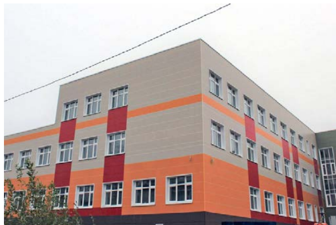
Новая школа на 300 мест с дошкольным отделением на 100 мест в пос. Осельки
