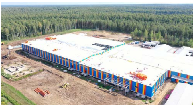
Расширение убойного цеха АО «Птицефабрика Северная»
