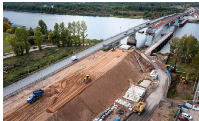
Пролет нового моста через р. Волхов в г. Кириши
