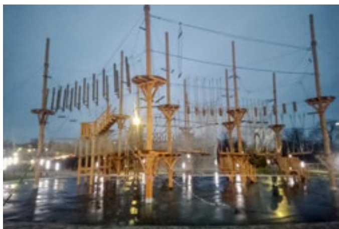
«Комплексное благоустройство Расстанной площади и прилегающих территорий»
