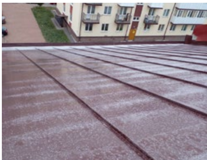
Ремонт крыши, (Всеволожский район, п. Щеглово, ул. Северная, д.35)
