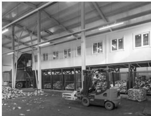
Комплекс по сортировке ТКО в Приозерском районе
