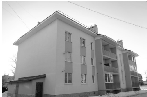
Ремонт фасада, (пгт. Мга, ул. Донецкая, д. 1)
