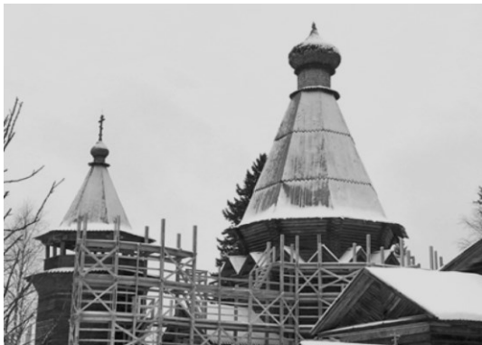
Установлены леса для реставрации здания «Никольской церкви (деревянной)», 1696 г., Подпорожский район, д. Созиницы
